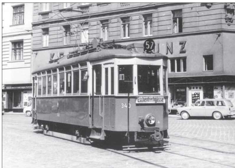
G4 340 in der Gumpendorfer Straße beim Lutherplatz.
