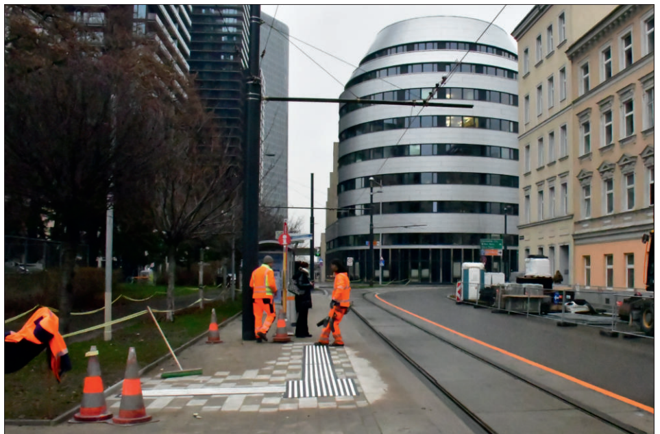
Anbringen der weißen Farbe auf den Bodenmarkierungen bei der Haltestelle Ludwig-Kößler-Platz in der Schnirchgasse.
