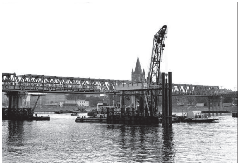
Mitte und unten: Die Belastungsprobe mit 24 Triebwagen. Fotos: Alfred Koranda/Archiv Bahn im Film, 6. und 8.10.1976
