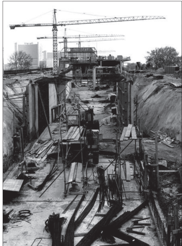
Beide Fotos: Bau des U1-Rampentunnels von der Lassallestraße zur neuen Reichsbrücke.
