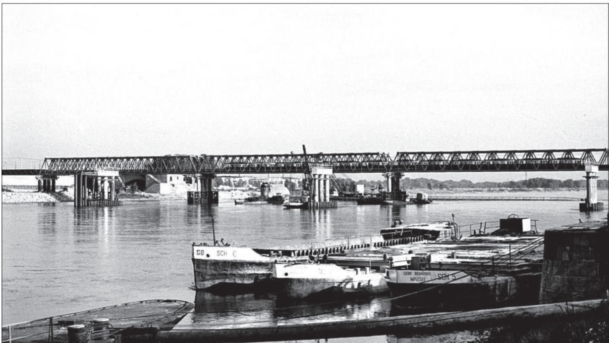
Mitte und unten: Die Belastungsprobe mit 24 Triebwagen. Fotos: Alfred Koranda/Archiv Bahn im Film, 6. und 8.10.1976
