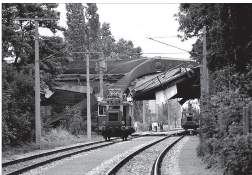
Begutachtung und Sicherung der Fahrleitung der Donauuferbahn.
