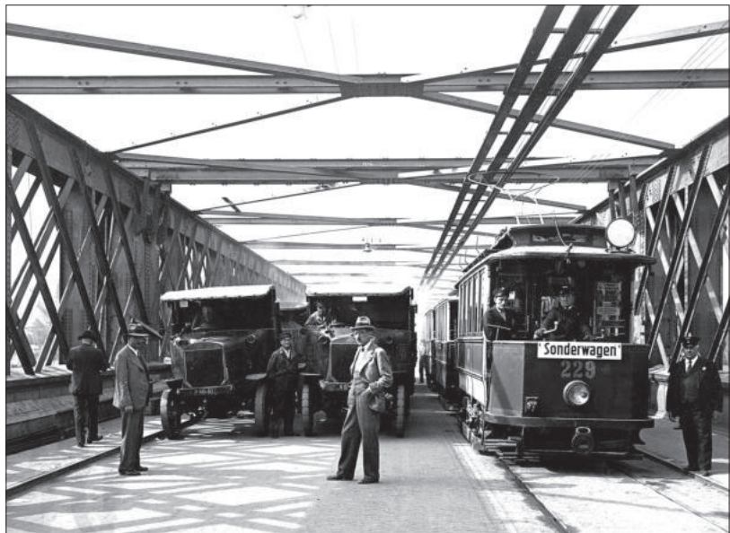
Belastungsprobe der alten Reichsbrücke im September 1934, vor Inbetriebnahme nach dem Verschieben. Foto: Wagner-Biro
