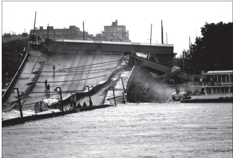
Die Bruchstelle bei der Kai- und Inundationsbrücke (Mitte) und bei der Inundationsbrücke (unten).
