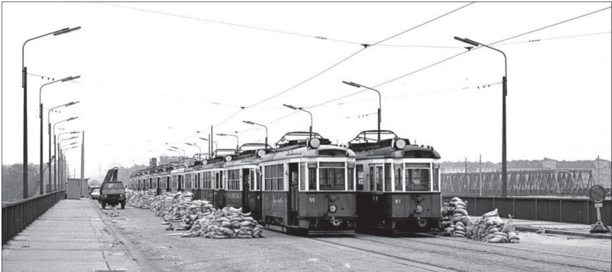
Die B-Triebwagen warten auf der Inundationsbrücke auf die Beladung mit den Sandsäcken, die als Balast dienen sollen. Foto: Alfred Koranda/Archiv Bahn im Film, 6.8.1976
