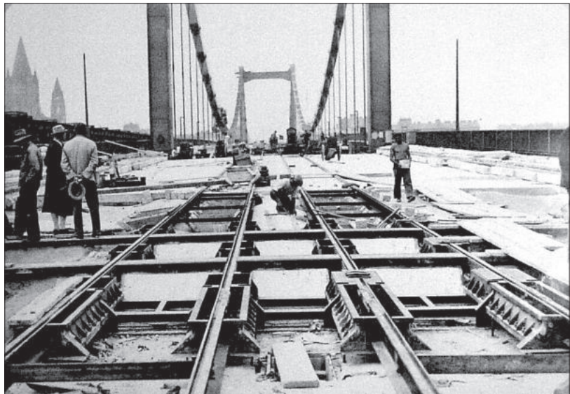
Belastungsprobe der alten Reichsbrücke im September 1934, vor Inbetriebnahme nach dem Verschieben. Foto: Wagner-Biro
