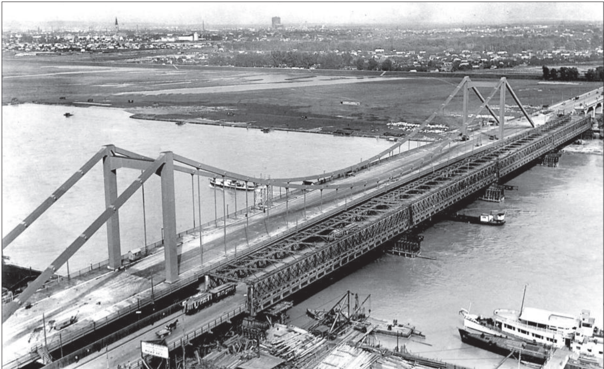
Neben der alten Reichsbrücke entstand die neue als (unechte) Kettenbrücke.
