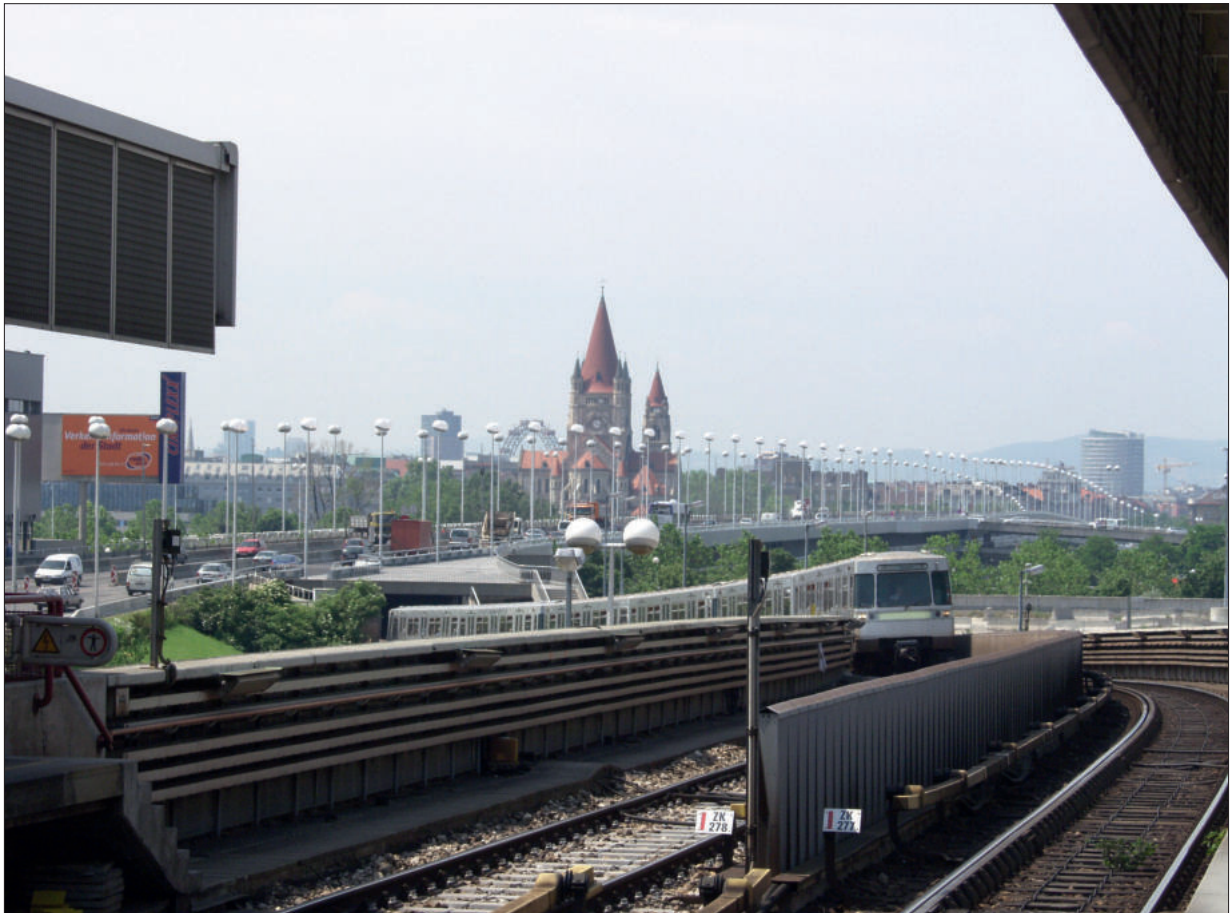
Oben: Die neue Reichsbrücke - eine eintönige, aber hochmoderne Spannbetonbrücke.
